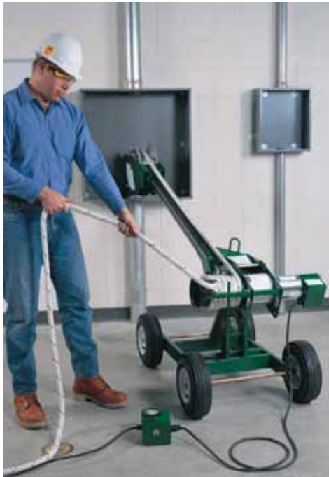
Вытягивание кабеля вверх с помощью устройства Ultra Tugger, установленного на передвижной тележке.
